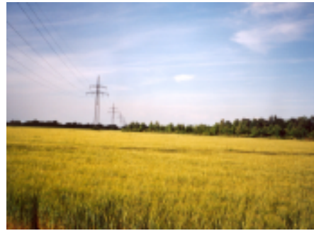
1B: Dieselbe Landschaft mit Freileitung
