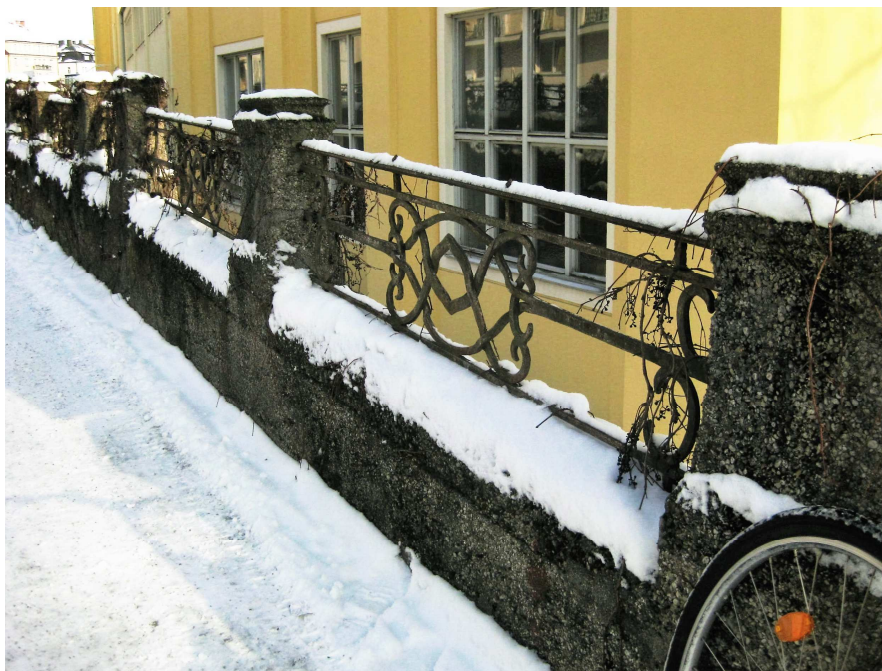
Abb. 8: Geländer zwischen Königinstraße und tiefer gelegenem Hauptgebäude
